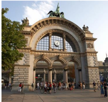
Torbogen Bahnhof Luzern
